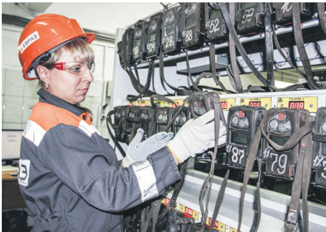
■ Татьяна Безбородова, электрослесарь дежурный и по ремонту оборудования, устанавливает переносные газоанализаторы на зарядную станцию
