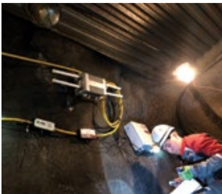
Рис. 4. Оборудование системы Centrian, точка доступа Wi-Fi на излучающем кабеле в подземных выработках рудника Долинный, «Казцинк»
